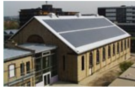
Photovoltaikanlage auf der Reithalle
